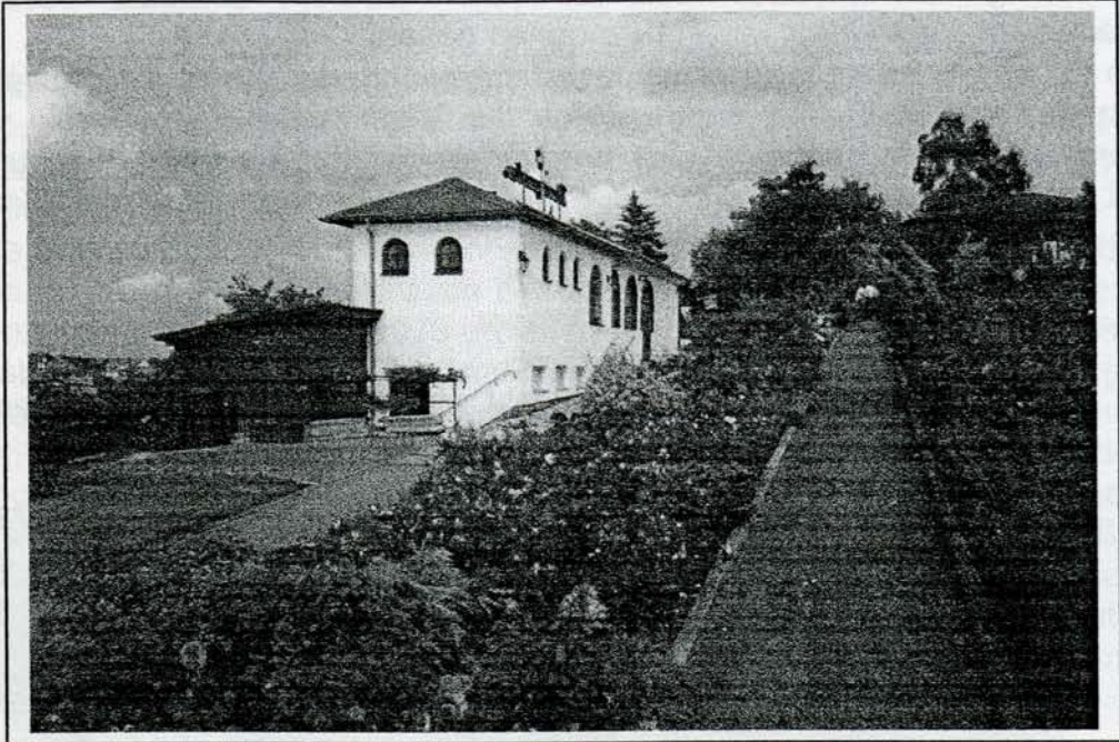
Anbau der Toilettenanlage am Pavillon des Rosengartens
